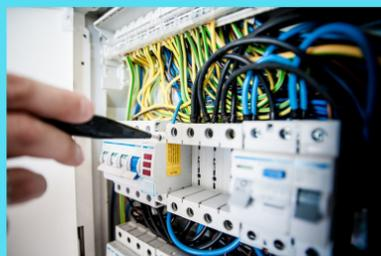
Outro dispositivo obrigatório nas instalações atuais é o disjuntor DR, usado para proteção dos equipamentos (como o disjuntor convencional) e como um diferencial em sua funcionalidade, atua com a detecção da corrente de fuga, e com isso desarma antes que a pessoa tome um choque. Serve portanto como proteção humana também.
